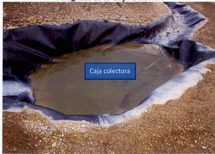
Fotografía N° 19: Vista de la caja colectora, perteneciente al canal de coronación C1.
