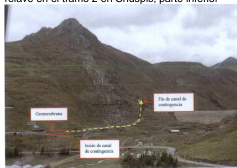
Foto 21: Concluida la construcción del nuevo canal de contingencia de concreto, se colocará geomembrana en el tramo inicial; en la actualidad aún no se coloca la geomembrana por el tránsito de personas que podrían tener accidentes y también dañar dicho material.
