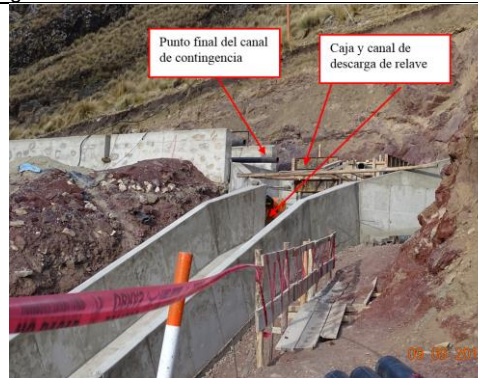
Foto 5: Tramo final del canal de contingencia de concreto
