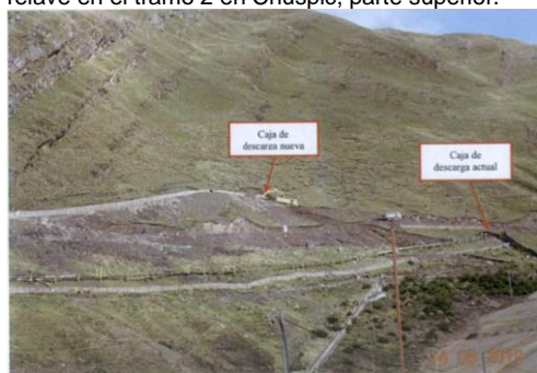
Foto 20: La construcción del nuevo canal de contingencia de concreto, no tendrá las mismas coordenadas finales determinadas por el OEFA, debido a que la caja de descarga de relaves será reubicada por el recrecimiento de la relavera.
