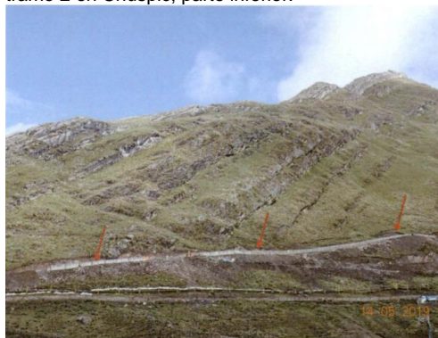
Foto 18: Construcción del nuevo canal de contingencia de concreto, para las tuberías de relave en el tramo 2 en Chuspic, parte superior.
