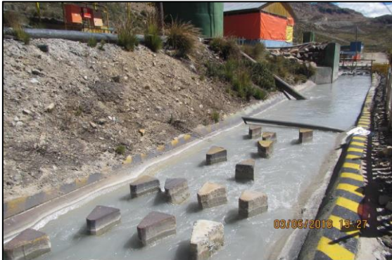
FOTOGRAFIA N° 09.- Área de generación de turbulencia. Cabe precisar que las aguas eran conducidas hacia la poza de sedimentación N°1 en forma de L.
