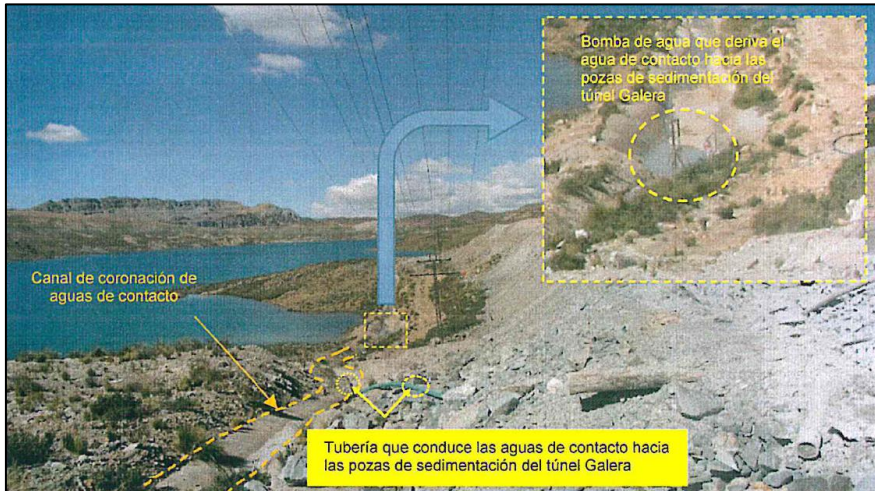
Fotografía N° 69: Vista del canal de coronación de las aguas de contacto, desde donde mediante una bomba de agua se deriva las aguas de contacto a través de una tubería HDPE hasta la poza de sedimentación N° 2, ubicada a la salida del túnel Galera.
