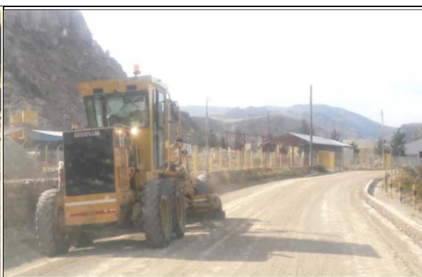
Fotografía 4. Trabajos de retiro de suelo impactado (Fuente: Reporte Final de Emergencia).
