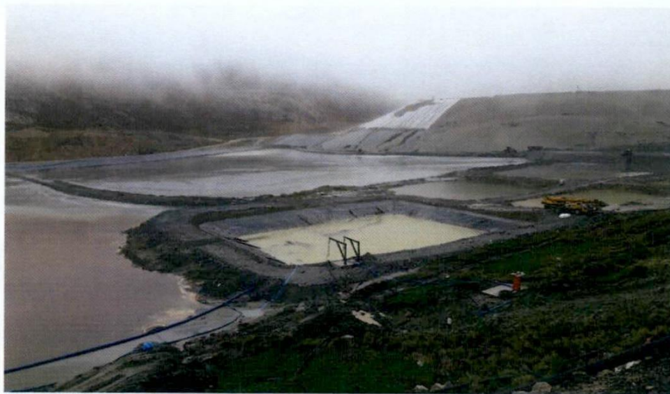
FIG. 3.3 Ubicación - Poza de Bombeo.
