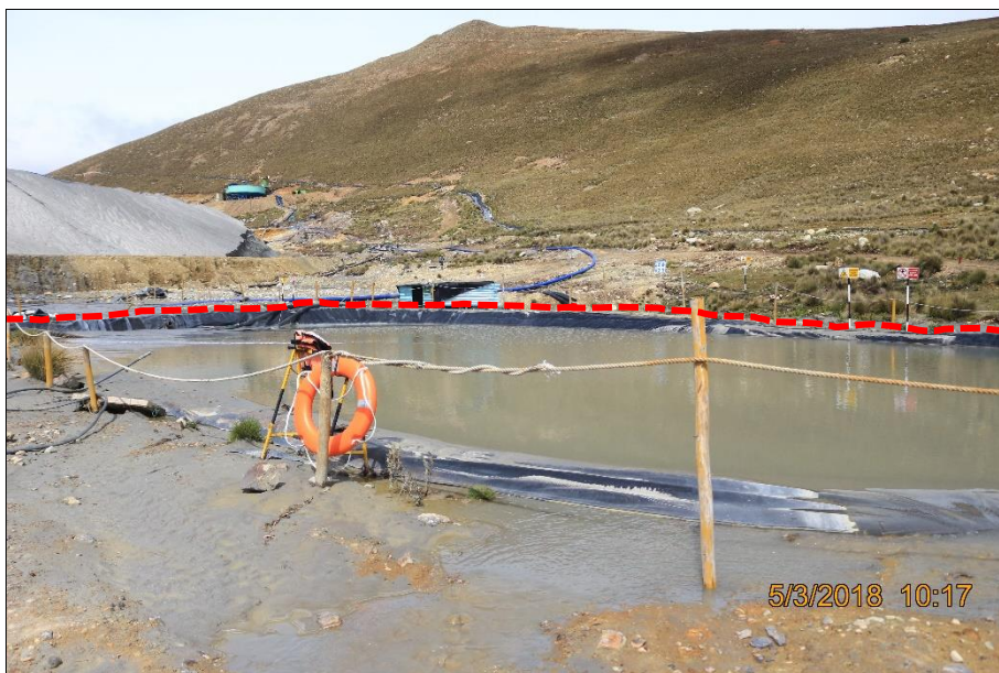
Fotografía N° 25: Poza de infiltración N°2 se encuentra ubicado en la quebrada Sipchoc aproximadamente a 150 metros del pie del dique de la relavera N°2 con coordenadas UTM WGS84 (222694E, 8921641N).
