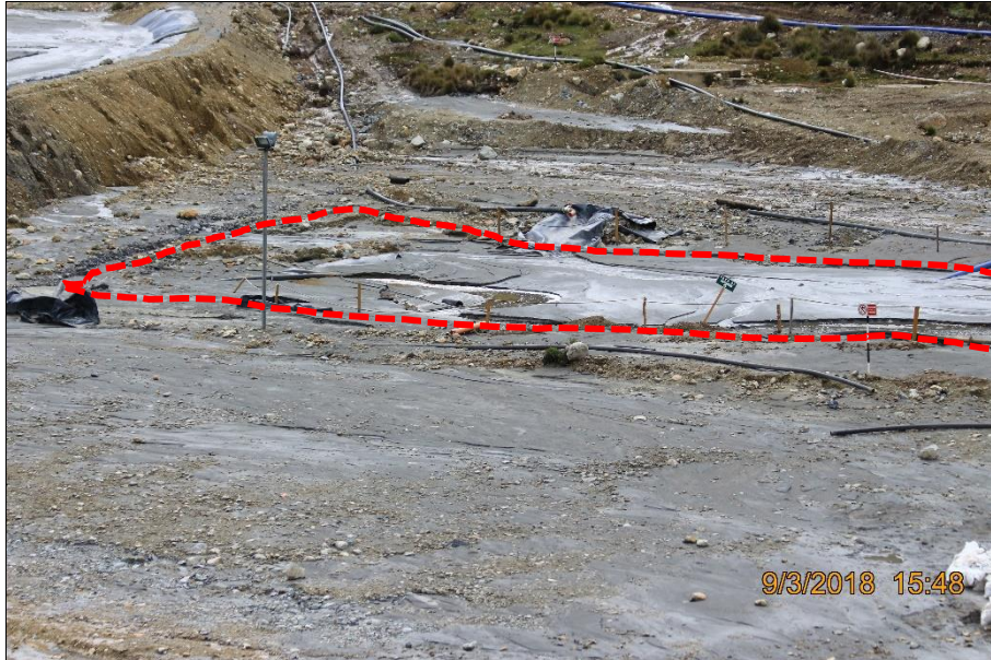
Fotografía N° 20: Poza de infiltración N°1, Nótese, la posa colmatada por finos a causa del evento suscitado en el Depósito de Relaves N°2.
