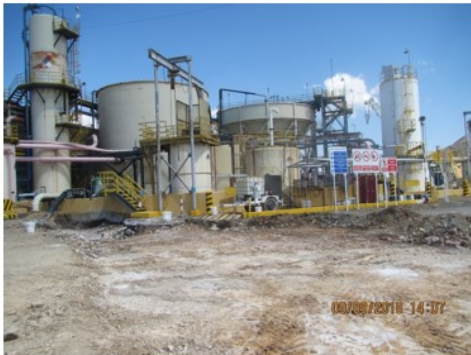
Fotografía 3: Zona N° 1 que entró en contacto con la solución cianurada, con coordenadas Datum WGS 84 N: 8951916 E: 0216356, con un área aproximada de 386.25 m 2 , donde se verificó que el administrado delimitó los límites físicos del derrame, colocó barreras de contención, acopió suelo industrial con solución cianurada. Asimismo, se observó una sustancia blanquecina en la superficie que estuvo en contacto con la solución cianurada, a lo cual el administrado refiere correspondería a hipoclorito de sodio en solución.
