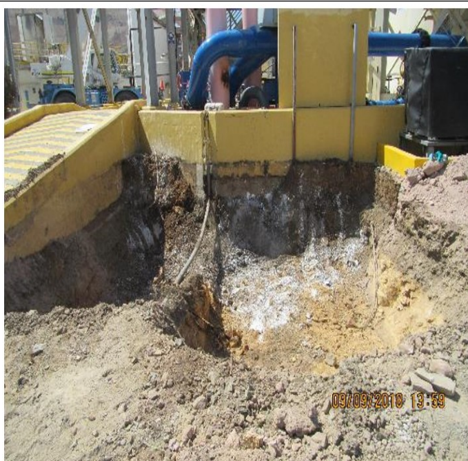
Fotografía 8: Zona N° 3 que entró en contacto con la solución cianurada, con coordenadas Datum WGS 84 N: 8951856, E: 0216356, con un área aproximada de 19 m 2 , donde se verificó que el administrado delimitó los límites físicos del derrame.
