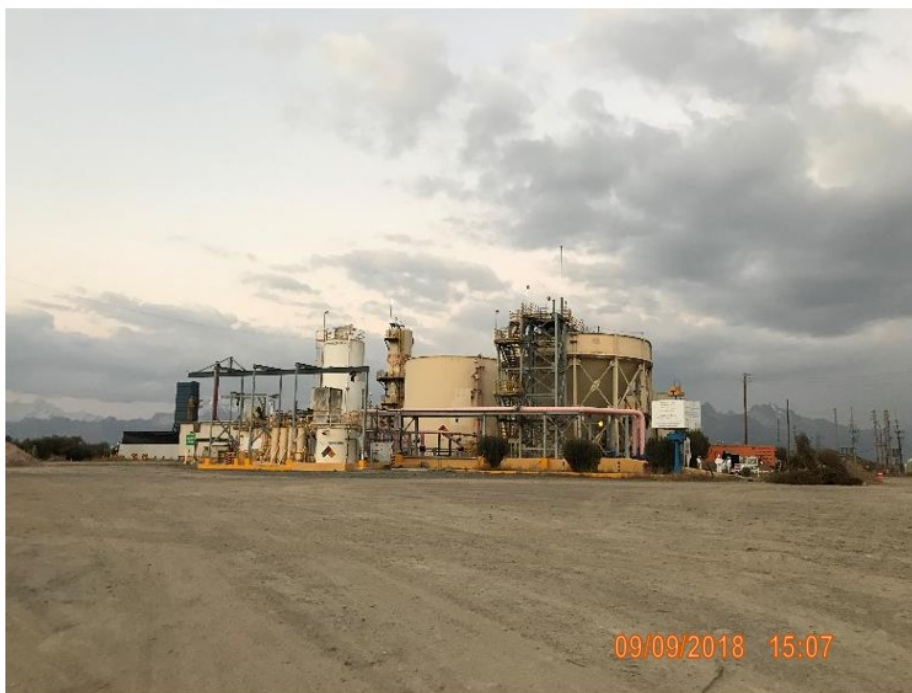
Fotografía 2: Planta de Procesos o Planta Merrill Crowe de la UM Pierina de titularidad de Minera Barrick Misquichilca S.A., donde ocurrió el evento reportado como emergencia ambiental por el rebose de una solución cianurada.
