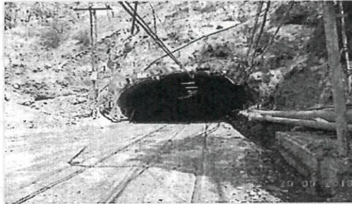
Fotografía N° 1. Bocamina Nv 28 Sur ubicada dentro de las instalaciones de la U.M. Cobriza, distrito San Pedro de Coris, Provincia de Churcampa, Departamento de Huancavelica
