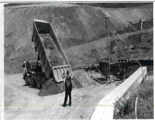
Foto 07: Traslado de material de préstamo para relleno en pozo Waz, 06 de enero de 2020
