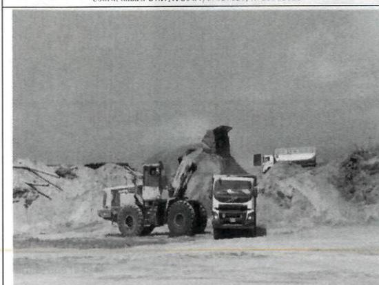
Foto 06: Traslado de material de préstamo para relleno en pozo Waz, 06 de enero de 2020
