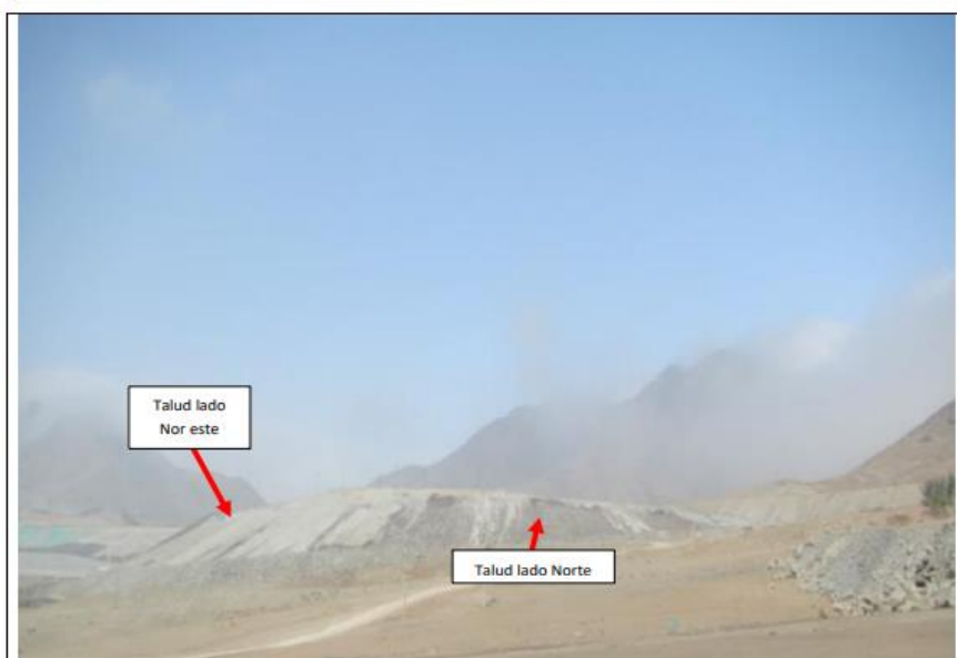
Fotografía N° 10. Vista panorámica del talud aguas abajo del depósito de relaves N°3, en el lado Norte y Nor Este en el que se verificó que el talud se encontraba sin manta de polipropileno. La vista fue tomada desde uno de los accesos ubicados en el lado norte del depósito.
