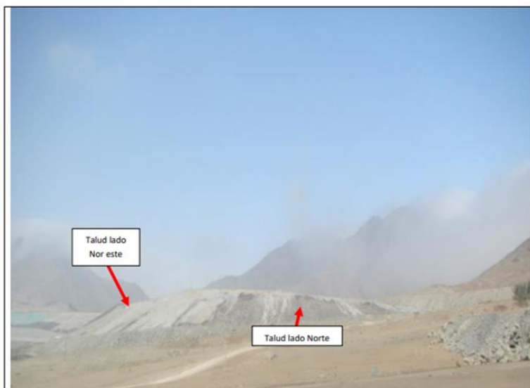
Fotografía N° 10. Vista panorámica del talud aguas abajo del depósito de relaves N°3, en el lado Norte y Nor Este en el que se verificó que el talud se encontraba sin manta de polipropileno. La vista fue tomada desde uno de los accesos ubicados en el lado norte del depósito.
