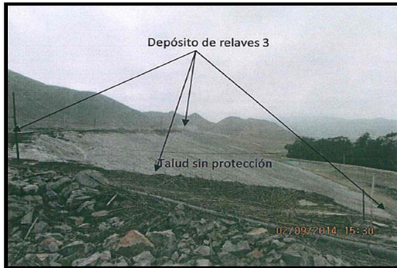
Fotografía N° 100: Hallazgo 1 – El talud aguas abajo del dique de la Presa de Relaves N° 3 se halla carente de protección contra la erosión eólica.
