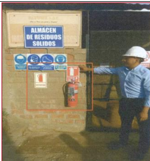
Se observa extintor el cual se encuentra señalado
