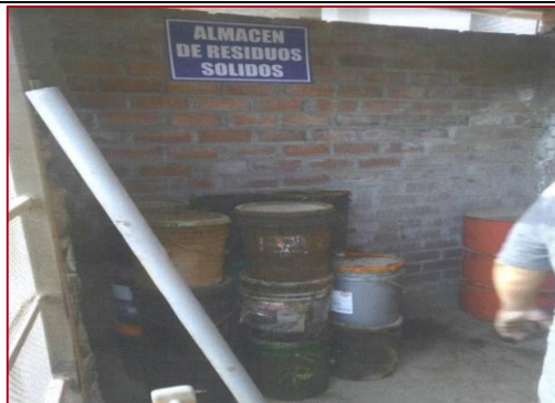
Interior del almacén central de residuos peligrosos.
