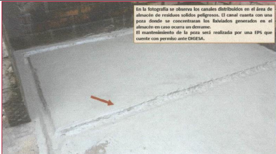
Acondicionamiento de canaletas de drenaje en el almacén central.
