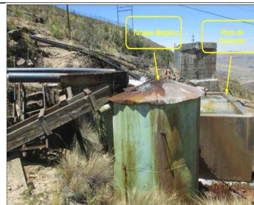
Fotografía N° 17: Vista fotográfica del tanque metálico donde llegaba el agua decantada para luego pasar a una poza de concreto.
