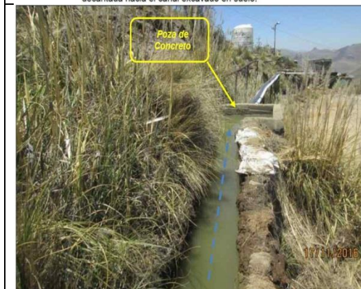
Fotografía N° 16: Vista fotográfica de la poza de concreto al cual llegaba el agua decantada para luego continuar el recorrido mediante tubería hacia tanque metálico.
