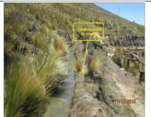
Fotografía N° 15: Vista fotográfica de la continuación de canal que se encontraba excavado en el suelo y el cual llevaba el agua decantada hacia la parte superior de la planta concentradora.
