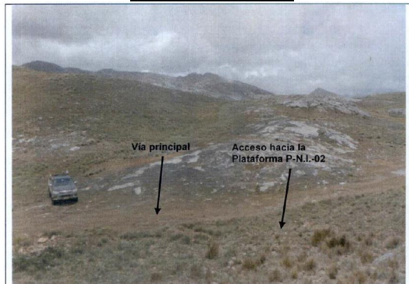
Fotografía N° 24. Acceso hacia la Plataforma No identificada P-N.I.-2.- Este acceso se inicia en la plataforma P-N.I.-2 (coordenadas UTM WGS 84 444539E, 8625271N y altitud de 4700 m.s.n.m.), y culmina en el empalme con el acceso principal (coordenadas UTM WGS 84 444578E y 8625296N), tiene un ancho de 4 m y una longitud de 25 m, esta área se encontraba revegetada.
