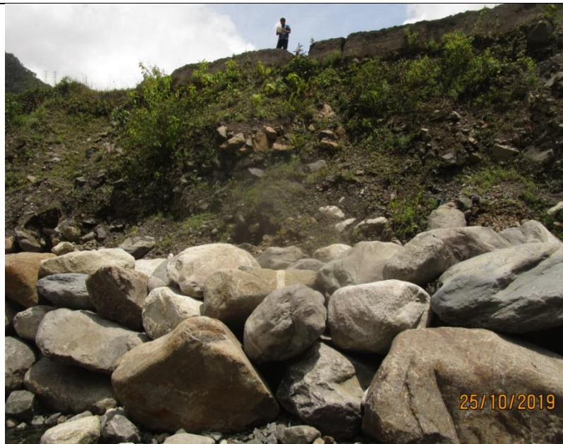
Vista del talud del DME-1 en la ribera de la margen derecha del río Chiamayo, con un enrocado en la base y con un bisel en la parte superior, asimismo se ve que el talud presenta vegetación.
