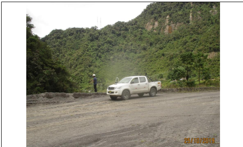
Se observa que la superficie superior del DME-1, en la zona del talud cercano al margen derecho del río Chiamayo, se encuentra correctamente nivelada y sin presencia de grietas.
