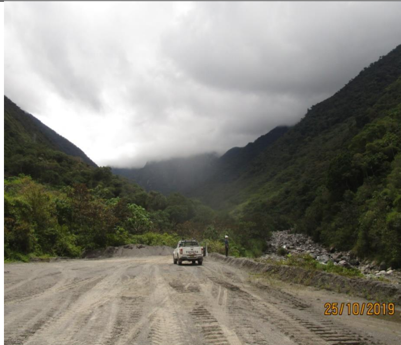
Otra vista de la superficie superior del DME-1, sin presencia de grietas y con un bisel en el borde del talud a modo de contención.
