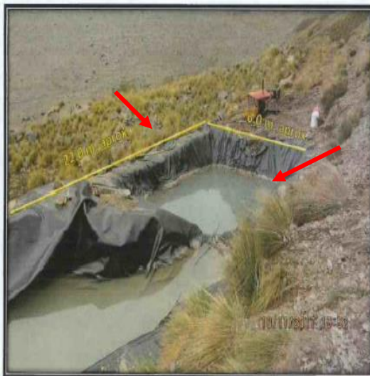
Fotografía N° 25: Presunto Incumplimiento N° 2. Vista Panorámica de la poza de almacenamiento de agua sin identificación, ubicada en las coordenadas UTM WGS 84 – Zona 18: N 8 766 413, E 334 328 y altitud 4 694 m.s.n.m., se observó una poza revestida con geomembrana, que contaba con dimensiones aproximadas de 22 metros de largo y 6 metros de ancho. El largo y ancho aproximados de la plataforma se obtuvo de las coordenadas (UTM-WGS84): 8766308N; 334331E, 8766421N; 334328E, 8766424N; 334332 y 8766402N; 334337E.
