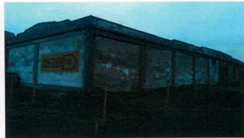
Figura 4: Recojo de materiales circundantes a la edificación de ex taller de contratistas y señalización.
