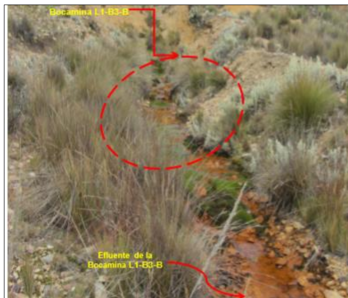
Vista de la bocamina L1-B3-B, ubicado en las coordenadas UTM (WGS 84), E: 222298 N: 8923169, se encuentra tapada con material propio, además, se observa vegetación a su alrededor, y un efluente de coloración naranja.
