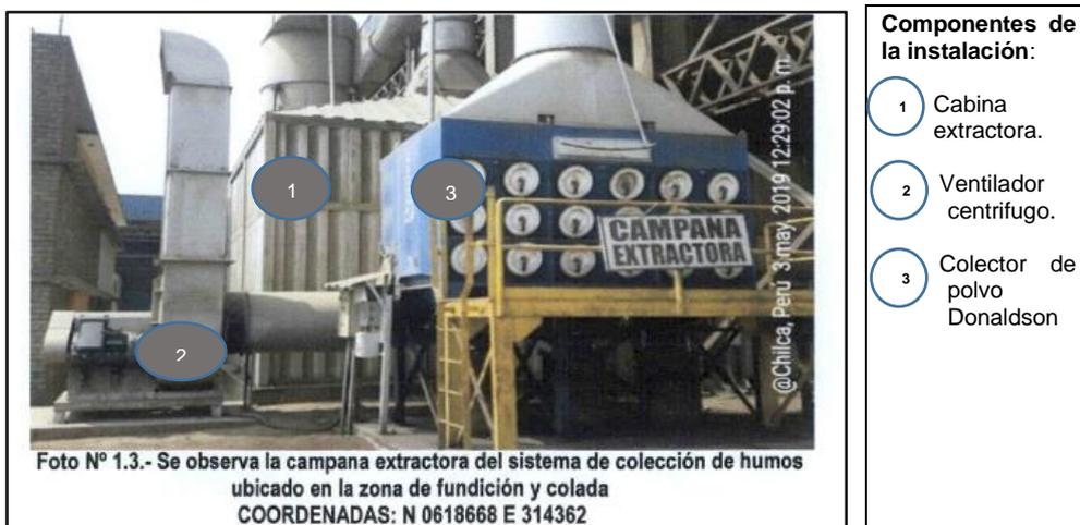
Foto N° 1.3.- Se observa la campana extractora del sistema de colección de humos ubicado en la zona de fundición y colada
