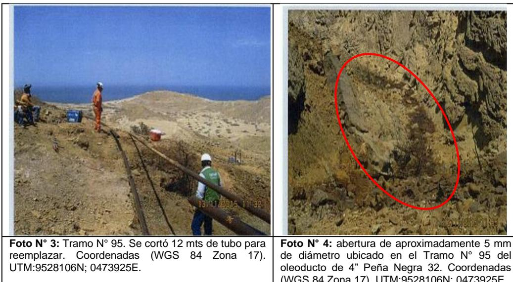
**Foto N° 3:** Tramo N° 95. Se cortó 12 mts de tubo para reemplazar. Coordenadas (WGS 84 Zona 17). UTM:9528106N; 0473925E.
