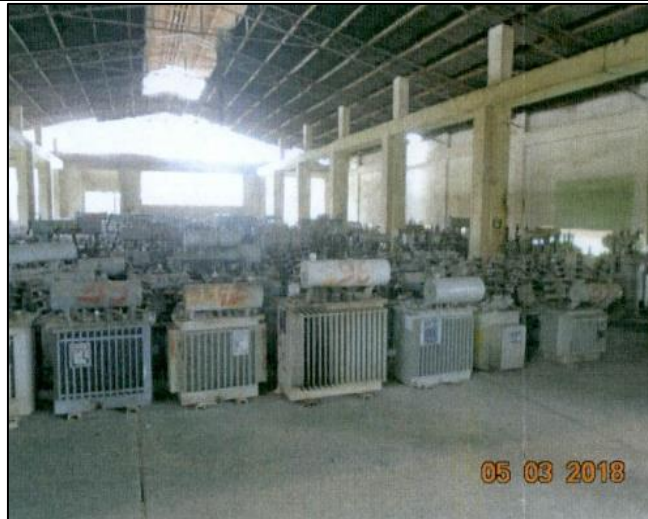
Fotografía 1 del Informe de Supervisión
