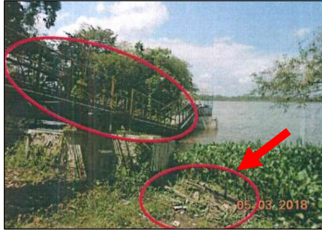
Fotografía 24 del Informe de Supervisión
