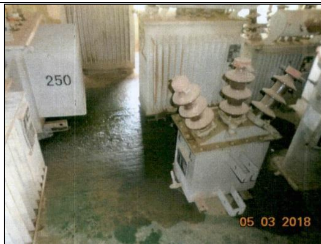
Fotografía 4 del Informe de Supervisión
