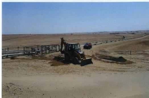
Fotografía 6 Aplicación del Plan de Contingencias - Planificación de la recolección con maquinaria, de suelos impactados.
