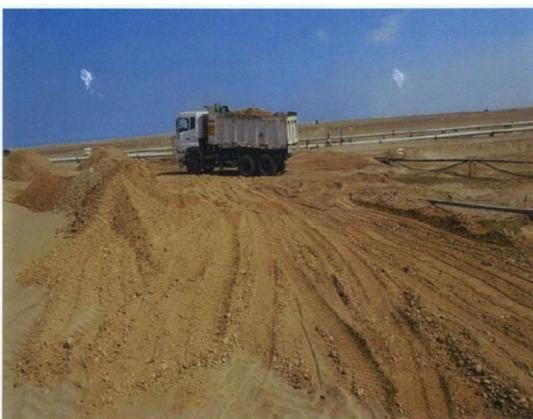
Fotografía 11: Aplicación del Plan de Contingencias - Inicio del proceso de restauración del área afectada (Se transportó material de la zona)
