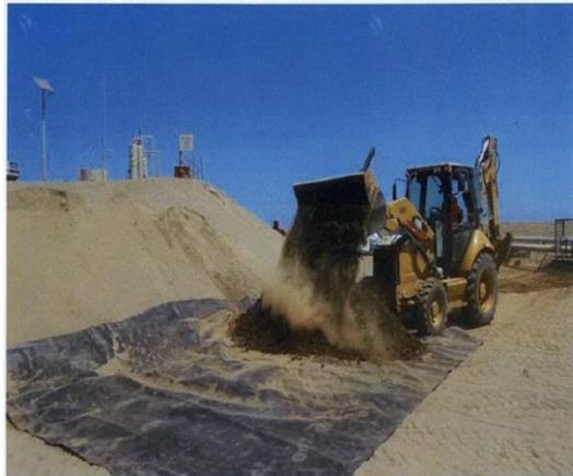
Fotografía 7: Aplicación del Plan de Contingencias - Impermeabilización con Geomembrana y recolección de suelos contaminados con maquinaria (Lugares alejados del ducto)
