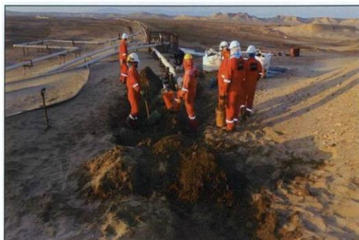
Fotografía 5 Aplicación del Plan de Contingencias - Recolección de Suelos contaminados con Personal (Zona Cercana al Ducto) - Nótese el uso de la geomembrana debajo de las sacas de suelos contaminados.
