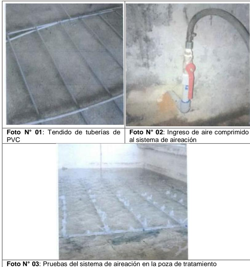
44. Del análisis de las mencionadas fotografías, se observa que en una poza se implementó una red de tuberías de PVC que presentan unos orificios, por donde sale el aire que es alimentado. No obstante, se puede evidenciar que las fotografías no se encuentran geo-referenciadas.
