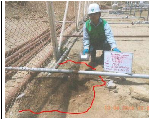
Foto N° 48. Ingreso a la Batería TA-24 de la línea de Prueba del manifold MC-6A, se observó suelo impregnado con hidrocarburo, en un área aproximada de 0.70 m x 0.60 m a una profundidad de 0.30 m. (Coordenadas UTM: 474964E - 9524869N)
