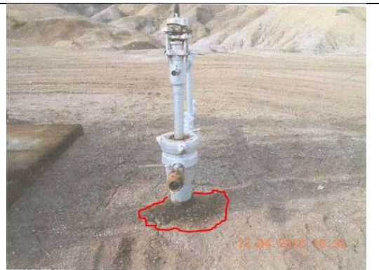
Foto N° 45. Alrededor del pozo EA-2016, se observó suelo impregnado con hidrocarburo, en un área aproximada de 0.50 x 0.50 m a una profundidad de 0.30 m. Coordenadas UTM Sistema WGS84 474123E 9523646N
