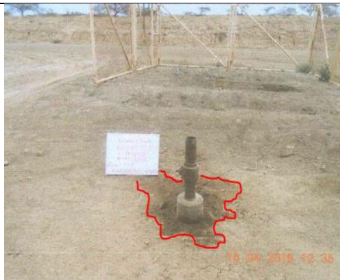
Foto N° 52. Alrededor del pozo EA-8583 (tubing swab), se observó suelo impregnado con hidrocarburo en el área afectada es de 1.00 m x 1.00 m a una profundidad de 0.08 m. (Coordenadas UTM: 477547 E - 9529403 N).
