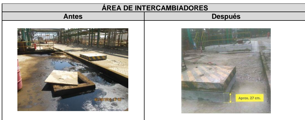
Imagen N° 1. Área de intercambiadores – Incremento en la altura del muro del buzón
