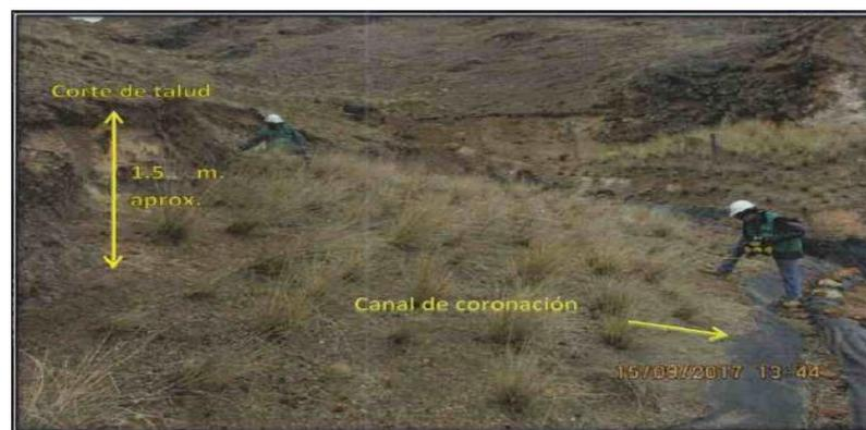
Fotografía N° 12: Presunto incumplimiento N°1: Vista Panorámica PLAT-299 Ubicada en las coordenadas UTM WGS 84 – Zona 18: N 8 593 131, E 493 733 y altitud 4 583 m.s.n.m. La plataforma no contaba con una topografía acorde a la del terreno circundante y presentaba un corte en el talud y presencia de canal y la presencia de un canal de coronación de aproximadamente 20 metros de largo, 1 metro de ancho y 0.30 metros de profundidad.
