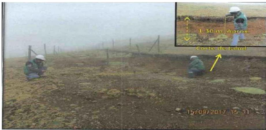
Fotografía N° 19: Presunto incumplimiento N°2: Vista Panorámica del Acceso hacia la Plataforma de perforación PLAT-021 Ubicado en las coordenadas UTM WGS 84 – Zona 18: N 8 594 081, E 493 169 y altitud 4 581 m.s.n.m. El acceso no se encontraba revegetado y presentaba un corte de talud de aproximadamente 1.3 metros de altura.
