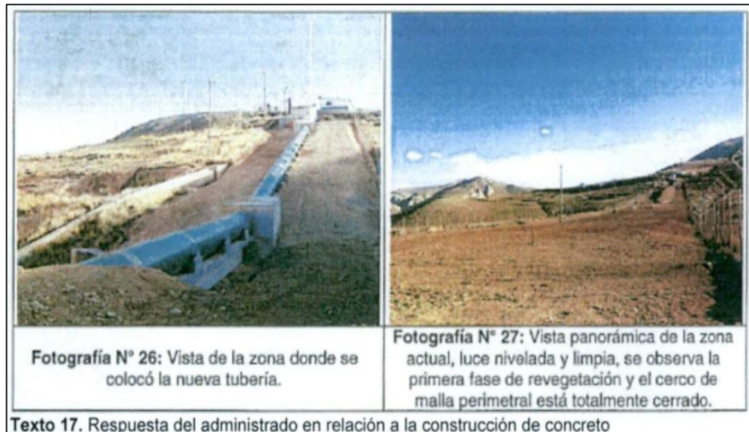
Imagen N° 13: Nueva tubería de presión
