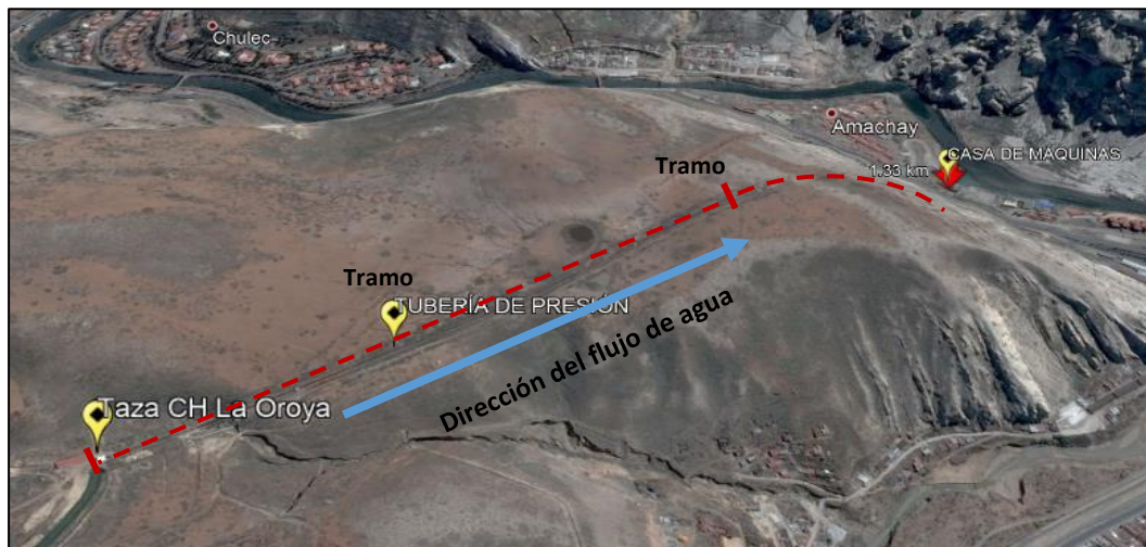
Imagen N° 8: Taza y tubería de presión de la CH La Oroya en el año 2014
