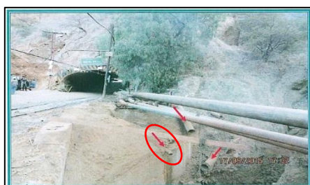
Fotografía N° 43: Una de esas tuberías es de 4" de diámetro, el cual presentaba un goteo no continuo y que caía a dicha poza. La segunda tubería es de 6", metálica, la cual según manifestación del titular minero se usa para casos de contingencia, en caso falle o se realice un mantenimiento a la tubería de 12" que ingresa a interior mina llevando agua que proviene del río Huarbamba, y una tercera tubería de 8" el cual según manifestación del titular minero cumplía la función de drenaje de una tubería antigua de transporte de agua del río Huarbamba. La ubicación de la poza está en las coordenadas UTM datum WGS84 8609849 N 0566234 E.
