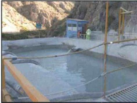
Fotografía 17.2: Poza 1, la de sedimentación. Recepciona el drenaje del "túnel ventana intermedia".
