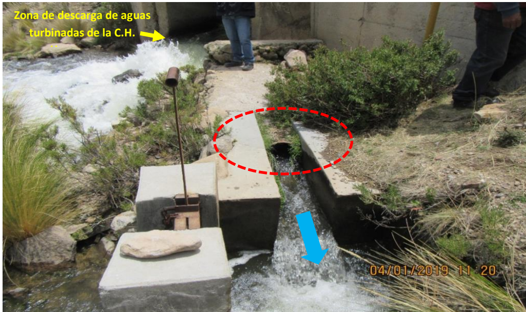
Fotografía N° H5-6: Vista desde aguas abajo del punto de captación de agua de la C.C. Huancarama, en donde se observa la parte final de la tubería que toma las aguas turbinadas de la C.H. Huancarama.
