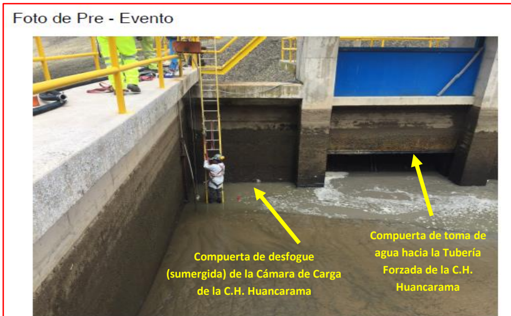
Imagen N° H2-4 del Informe de Supervisión: Captura de pantalla de la tercera página del RFEA en donde se muestra el ingreso de personal a la cámara de carga de la CH Huancarama para realizar la verificación del estado de la compuerta de desfogue previo a la ocurrencia de la emergencia ambiental.
