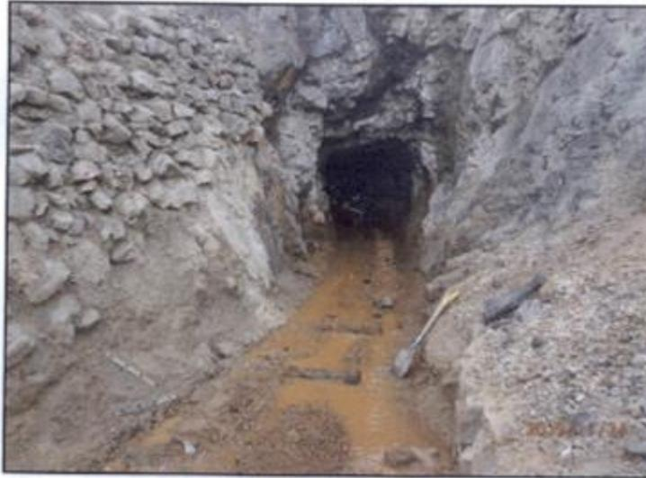
Foto 3: Se realizó el retiro total de las rieles, madera acumulada de la bocamina denominada "cortada 050 - Nivel 4825"
