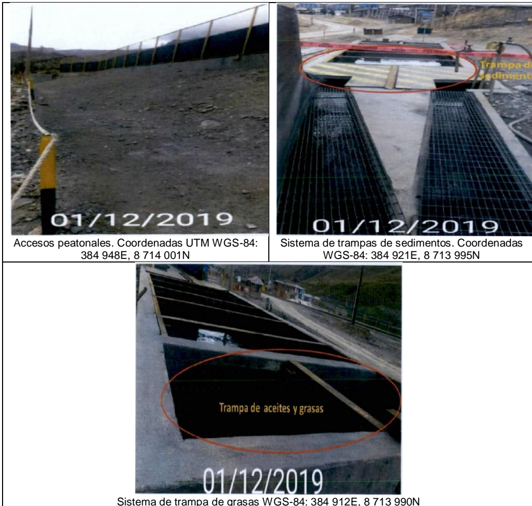
Sistema de trampa de grasas WGS-84: 384 912E, 8 713 990N
