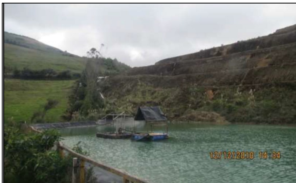
Fotografía N° 45: Al pie del Pad de lixiviación se verificó una poza de solución cianurada que tenía geomembrana, la poza tenía agua en su interior. Asimismo, se observó una balsa en estado de abandono.
