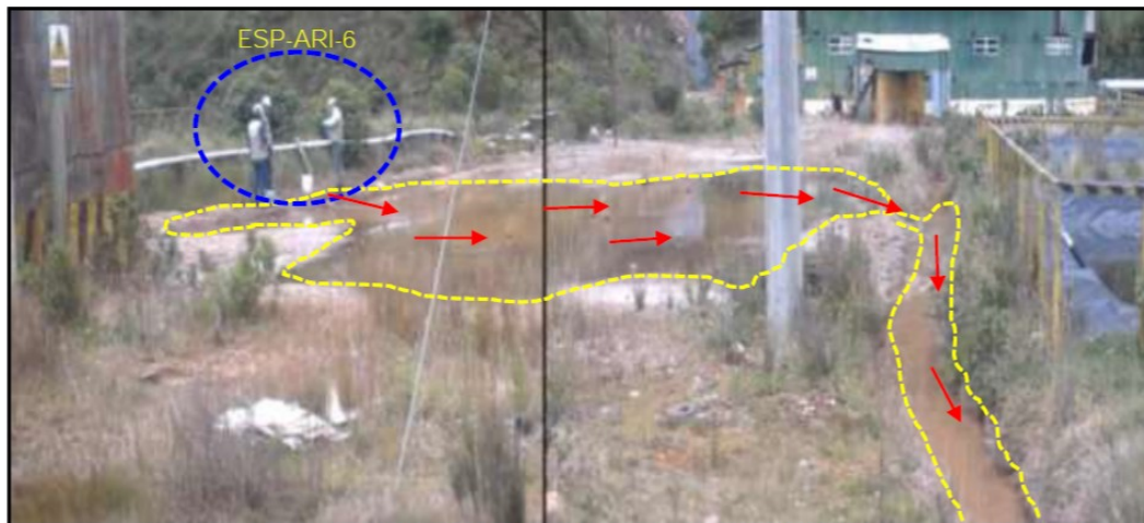
Fotografía N° 1: Filtración agua proveniente de una estructura de madera implementada adyacente a la poza de solución cianurada, ubicada en coordenadas UTM Datum WGS 84 (zona 17): N 9 254 201, E 760 190, y cota 3 665 m.s.n.m. Líneas de color rojo ( → ): representan el recorrido de la filtración hasta su descarga en la quebrada Tres Amigos.
