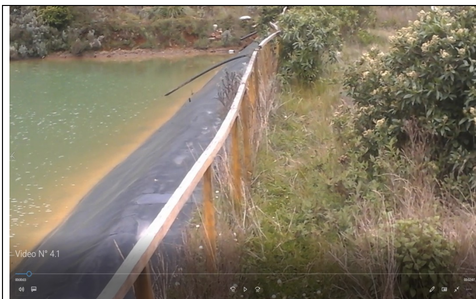
Imagen N°1: captura de imagen a los 2 segundos del video N°4.1, donde se aprecia el borde de la poza de solución cianurada recubierta con geomembrana y con líquido, el cerco de madera y vegetación alrededor de dicha poza.
