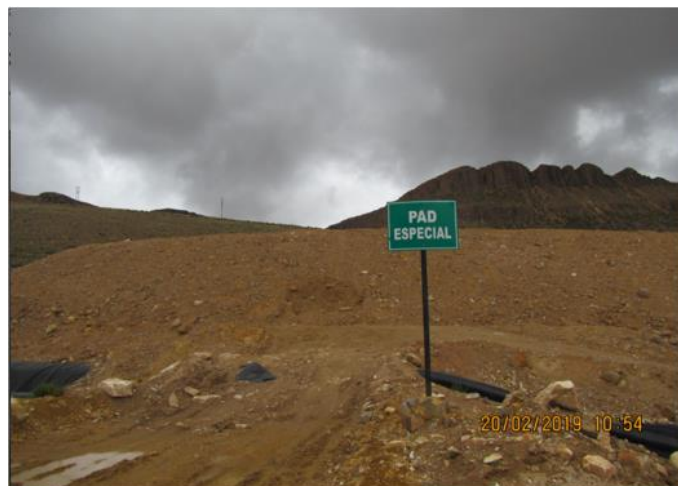
Fotografía "IMG_5638" conteniendo en el Anexo 9 del Acta de Supervisión: Vista de la una banqueta correspondiente al PAD Especial, donde se observó en su interior una grieta.
