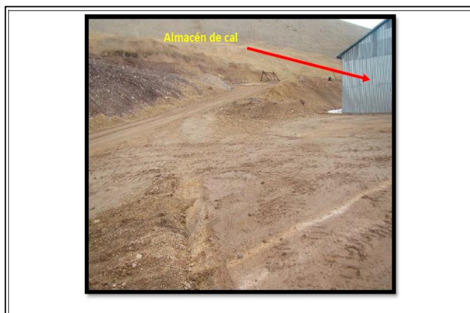
Fotografía N° 289. Vista del acceso hacia el almacén de cal.
