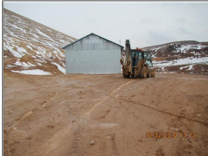
Fotografía N° 11. Vista del almacén de cal ubicado en la parte alta del pad de lixiviación, adyacente al punto de inicio del canal de coronación, este se encontraba cerrado.
