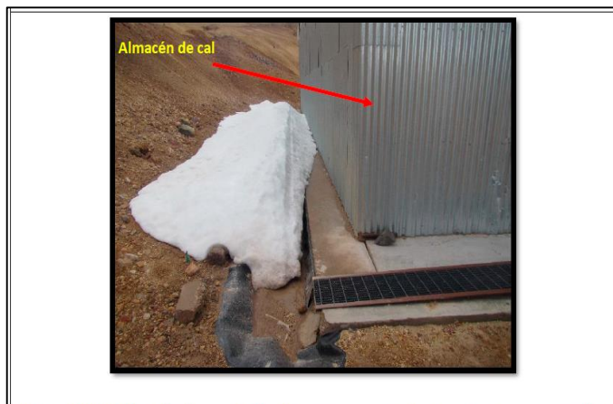
Fotografía N° 288. Vista del almacén de cal, estaba sobre una estructura de concreto y se ve parte de su canal perimetral.
