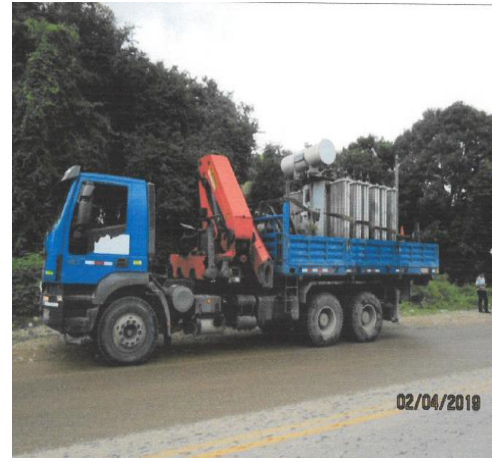
Vista fotográfica: Transporte del transformador inoperativo, retirado de la Ex Central Termoelectrica Juanjui.
