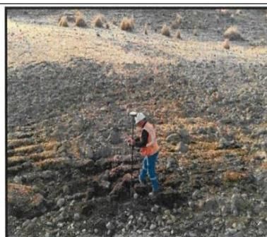
Fotografía N° 2: Replanteo y colocación de estacas - DME-10 / Vértice 5
