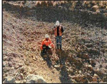
Fotografía N° 2: Replanteo y colocación de estacas – DME-10 / Vértice 4
