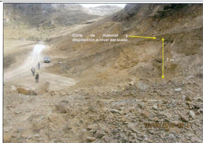
Fotografía N° 15: Cantera CA-01. Se observa el corte de material y un desnivel de 7 metros aproximadamente. Ubicado en las coordenadas WGS 84 zona 17 Norte 9 252 163, Este 764 122, cota de 3 557.
