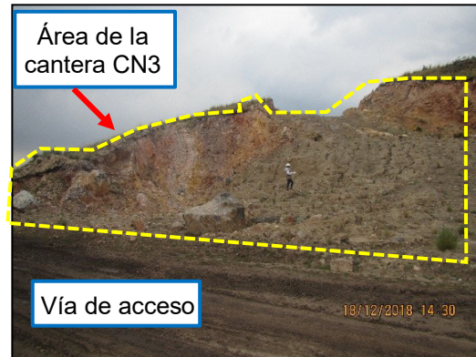
Fotografía N° 78. Vista de la cantera CN3, ubicada en las coordenadas UTM datum WGS 84 zona 19: 8 350 710N, 245 264E. Se observa el área excavada desde donde extrajeron material
