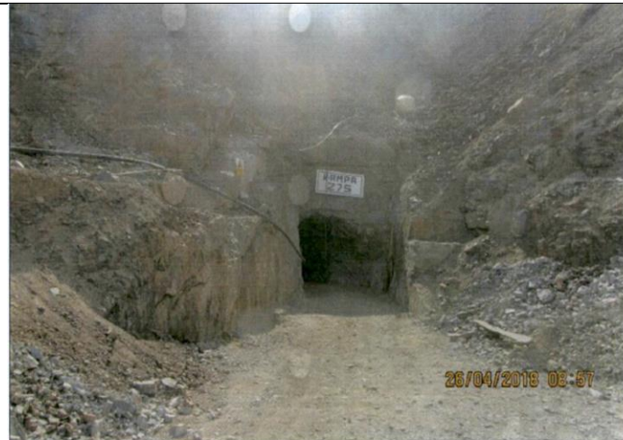
Fotografía N° 3. Vista de la Bocamina (Rampa 275) ubicada en las coordenadas WGS 84, N: 8 9057 75 y E: 813 815. Presentaba una dimensión de 3,60 metros de alto, 3,20 metro de ancho y 100 metros de profundidad. No se observó salida de agua desde su interior.
