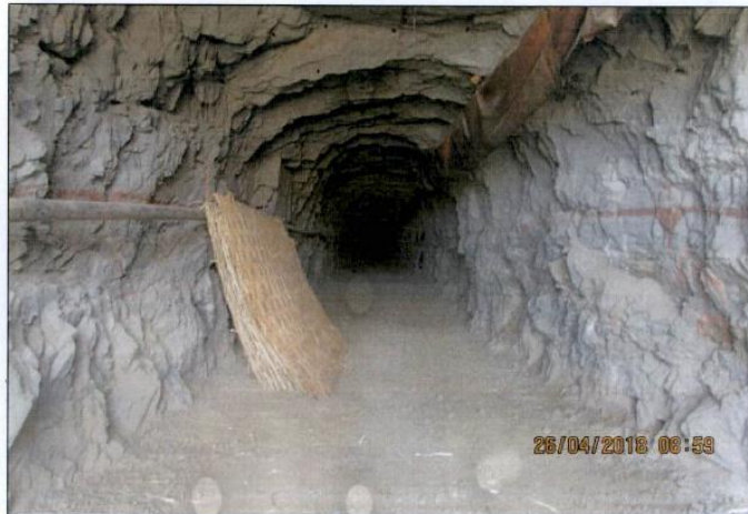
Fotografía N° 6. Vista de la Bocamina (Rampa 275). Presentaba una dimensión de 3,60 metros de alto, 3,20 metro de ancho y 100 metros de profundidad. No se observó salida de agua desde su interior.
