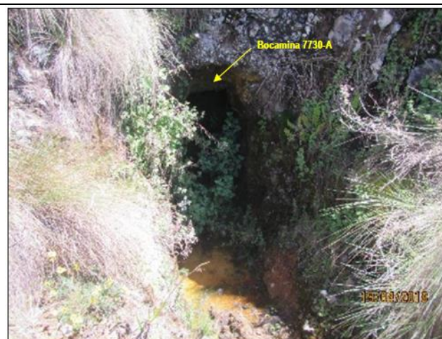
Fotografía N° 41: Otra vista de la Bocamina 7730-A. No presentaba efluente, sin embargo, se observó signos de haber contenido agua empozada. La bocamina no se encontraba cerrada de acuerdo al PCPAM Cleopatra.
