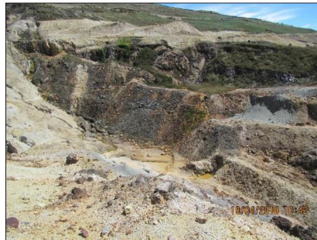
Fotografía N° 37: Tajo 7724. Ubicado en las coordenadas UTM WGS 84 Zona - 17: N 9255615; 758805. Se observó que el tajo no se encontraba cerrado de acuerdo al PCPAM Cleopatra.
