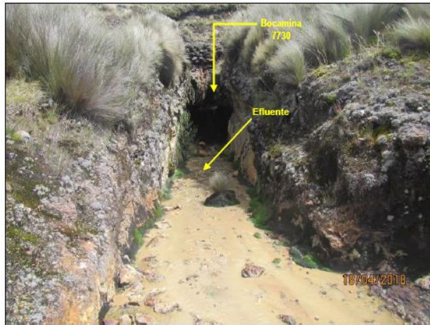
Fotografía N° 3: Otra vista de la Bocamina 7730. Se observó la entrada de la bocamina, la cual se encontraba abierta y presentaba drenaje de efuyente.
