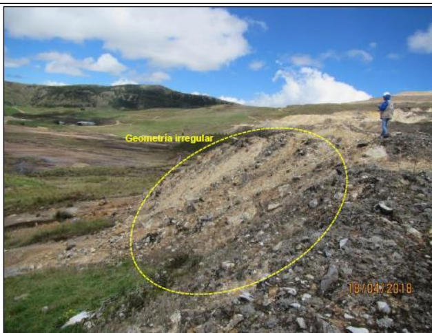
Fotografía N° 13: Depósito de Desmonte 7736. Ubicado en las coordenadas UTM WGS 84 - Zona 17: N 9255820; E 759125. El talud del depósito presentaba geometría irregular. El depósito se encontraba expuesto a la intemperie.
