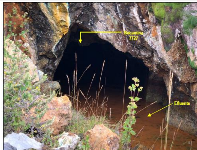
Fotografía N° 28: Otra vista de la Bocamina 7727. Presentaba efluente y agua empozada en la salida. Se apreció que la bocamina no se encontraba cerrada de acuerdo al PCPAM Cleopatra.
