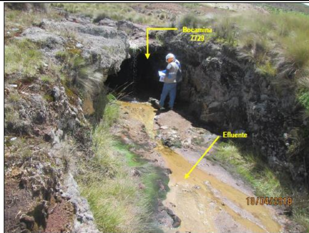
Fotografía N° 18: Bocamina 7729. Ubicada en las coordenadas UTM WGS - 84 Zona 17: N 9255710; E 759093. La bocamina se encontró abierta, presentaba drenaje de efluente que discurría con dirección hacia el bofedal en la cabecera de microcuenca de la Quebrada Sinchao. La bocamina no se encontraba cerrada de acuerdo al PCPAM Cleopatra.
