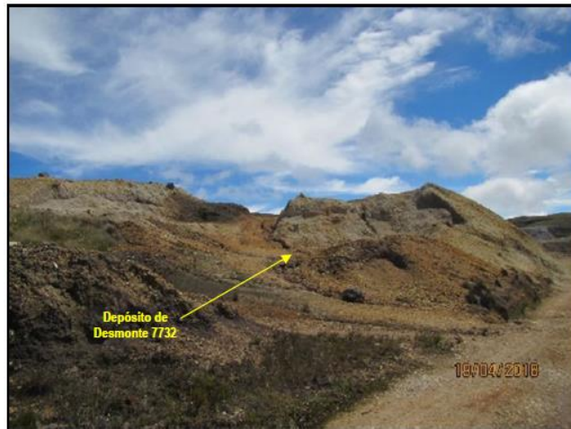
Fotografía N° 36: Depósito de Desmonte 7732. Ubicado en las coordenadas UTM WGS 84 Zona 17 N 9255546; E 758823. Se observó agua empozada sobre la cresta del talud. El depósito se encontraba expuesto a la intemperie.
