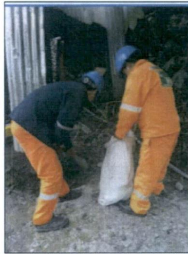
"FOTO N° 03 (Coordenadas UTM WGS84 8489314N; 337162E) / Fecha de foto: 17-04-2018. Se remedió agua oleosa retenida en losa de concreto".
