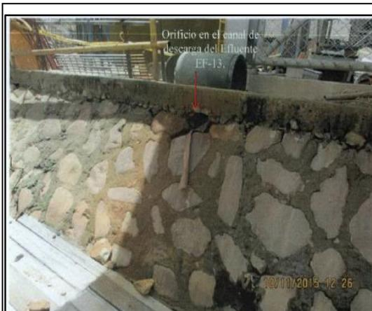
FOTOGRAFIA N° 17: Hallazgo 2. Vista del canal de descarga del EF-13 al río Shorey, que lleva las aguas provenientes de la planta de neutralización.
