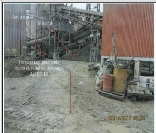
FOTOGRAFIA N° 16: Hallazgo 2. Vista en detalle del mineral acumulado y la pendiente que direcciona el agua hacia el canal de descarga del efluente EF-13. Dicho canal lleva sus aguas hasta el río Shorey, donde descarga el referido punto de control.
