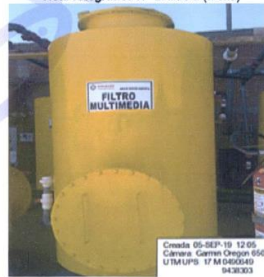
Vista fotográfica N° 4: filtro 4 (multimedia que ha reemplazado al segundo de cuarzo de la miniplanta)
