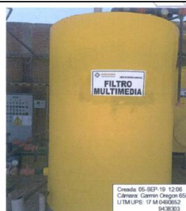
Vista fotográfica N° 6: filtro 6 (multimedia)
