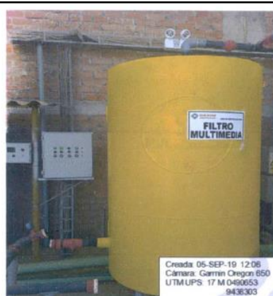
Vista fotográfica N° 5: filtro 5 (multimedia)
