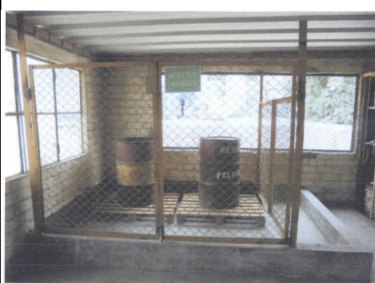
Fotografía N° 1 – Almacén Central de Residuos Peligrosos (aceites usados) con muro y losa de concreto cubierto por pulido de cemento.
