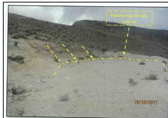
Fotografía N° 18. Incumplimiento N° 1: Otra vista del área de la plataforma DDH-601 y plataforma DDH-62, donde se observó que el área de la plataforma presentaba el corte del talud realizado en el terreno.
