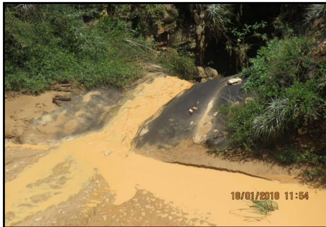
Fotografía 16. Vista de la Poza de Sedimentos, la cual se observó que se encontraba en su capacidad máxima de almacenamiento y saturada de sedimentos, con descarga a la quebrada Higuieron.
