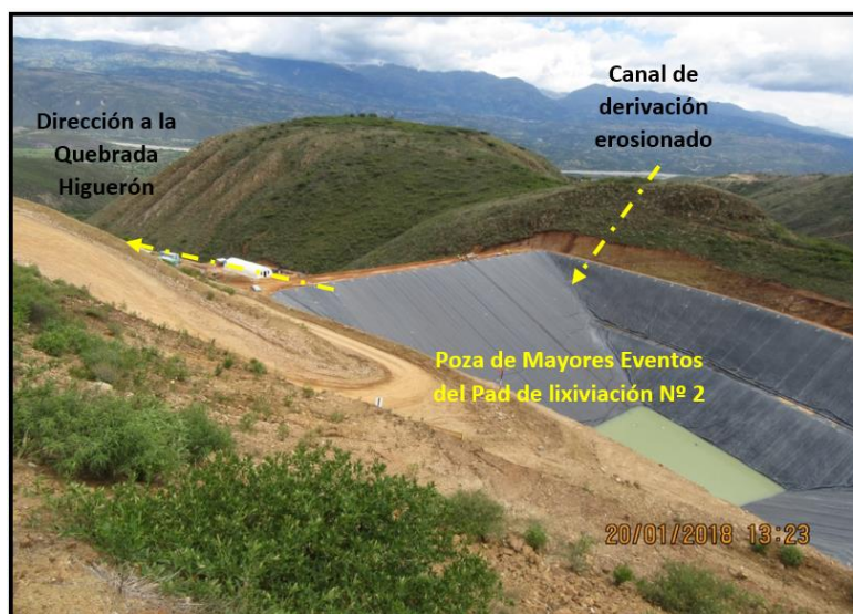
Fotografía 9. Nótese que la Poza de Mayores Eventos, se encontraba en proceso de construcción. Las instalaciones auxiliares como el sistema de bombeo y el sistema de detección de fugas todavía no habían sido instalados.
