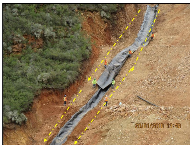
Fotografía N° 18. Vista de la colocación de geomembrana en el Canal de Perimetral 1C Tramo 2 que había sido erosionado.
