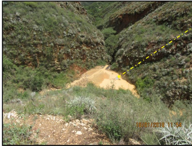
Fotografía 15. Vista de una de las pozas de sedimentación temporal en la quebrada Higuieron. Medida de control de sedimentos implementado durante la etapa de construcción del PAD de Lixiviación N° 2.
