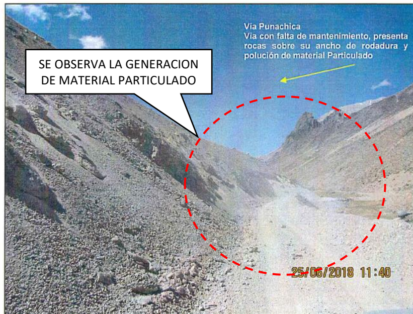
Fotografía N° 34: Vía Punachica con falta de mantenimiento, se verificó la presencia de rocas, desprendimiento de material del talud y material no compactado que facilita su polución al entorno. Ubicado en las coordenadas (Norte 8291511, Este 182999) al (Norte 8293238, Este 183328) y cota de 4718 en WGS 84 zona 19.
