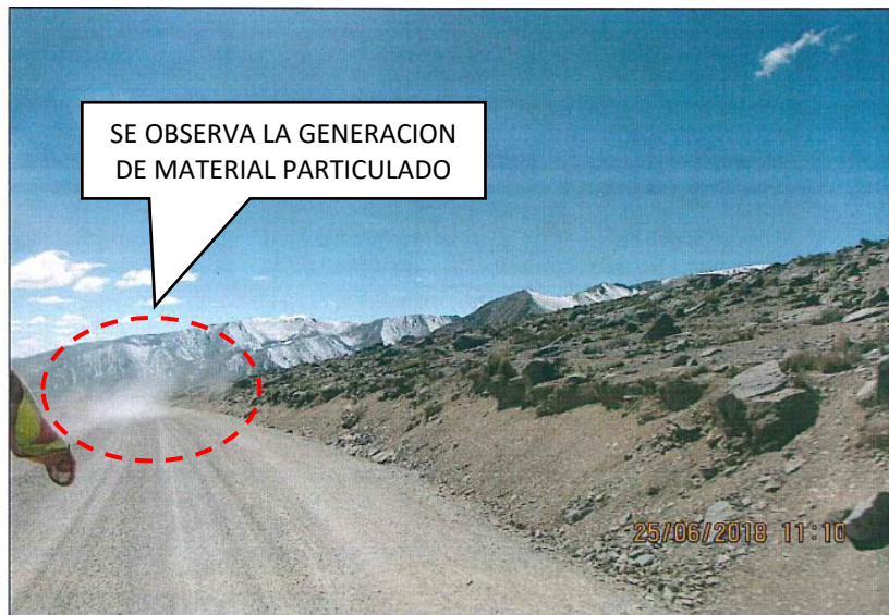
Fotografía N° 35: Vía Punachica de riego de vías, se verificó la presencia de rocas, desprendimiento de material del talud y material no compactado que facilita su polución al entorno. Ubicado en las coordenadas (Norte 8291511, Este 182999) al (Norte 8293238, Este 183328) y cota de 4718 en WGS 84 zona 19.
