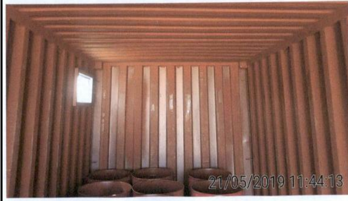
Foto N° 8. Almacén de residuos Peligrosos, sistema de ventilación.
