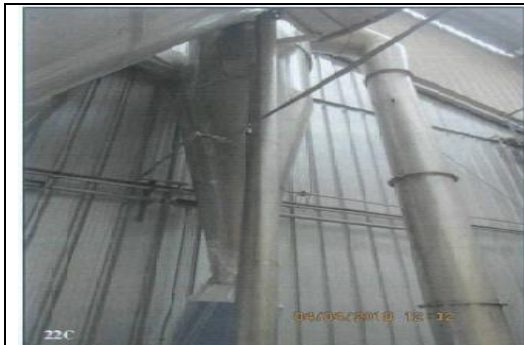
Fotografías N° 22 C y D: Vistas de la instalación de filtros mangas, líneas de acero inoxidable, entre otros, pertenecientes a la cuarta área ampliada.
