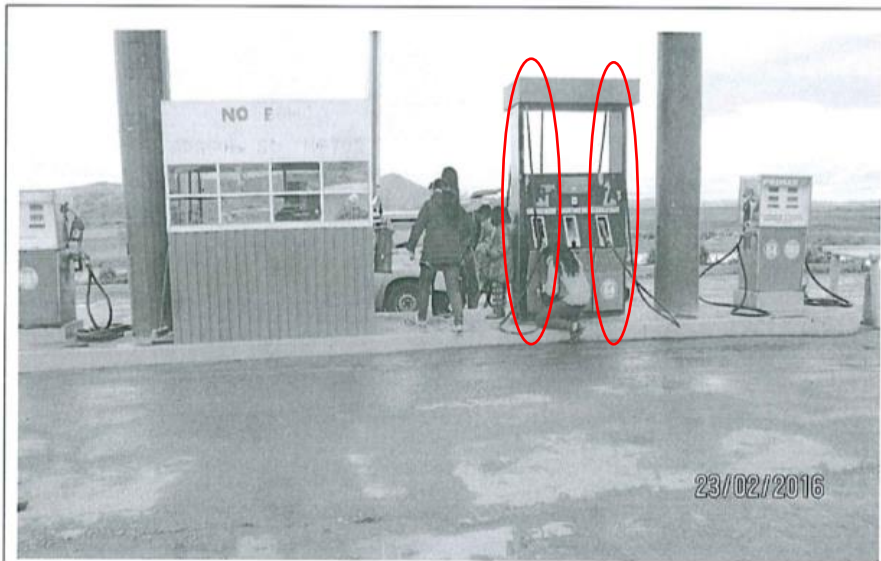
Fotografía N° 02.- Imagen del área de ubicación de expendio de combustible líquido del establecimiento, donde se aprecia 2 surtidores y 1 dispensador
