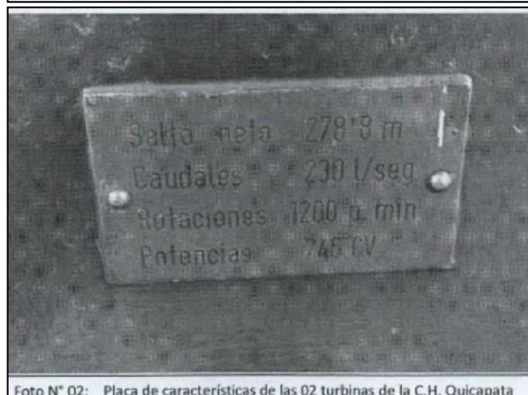
Foto N° 02: Placa de características de las 02 turbinas de la C.H. Quicapata
